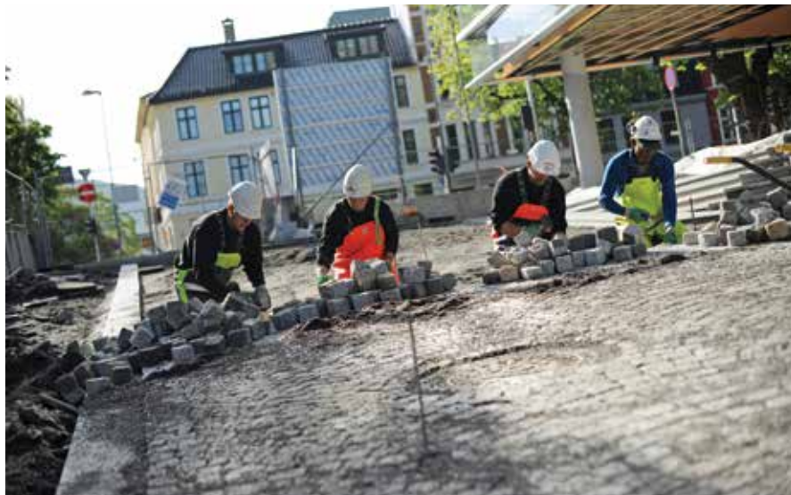
Figur 10. Dekket blir fuget etter hvert og legges med litt overhøyde før avsluttende komprimering av belegget. Foto: Svein Boasson AS
