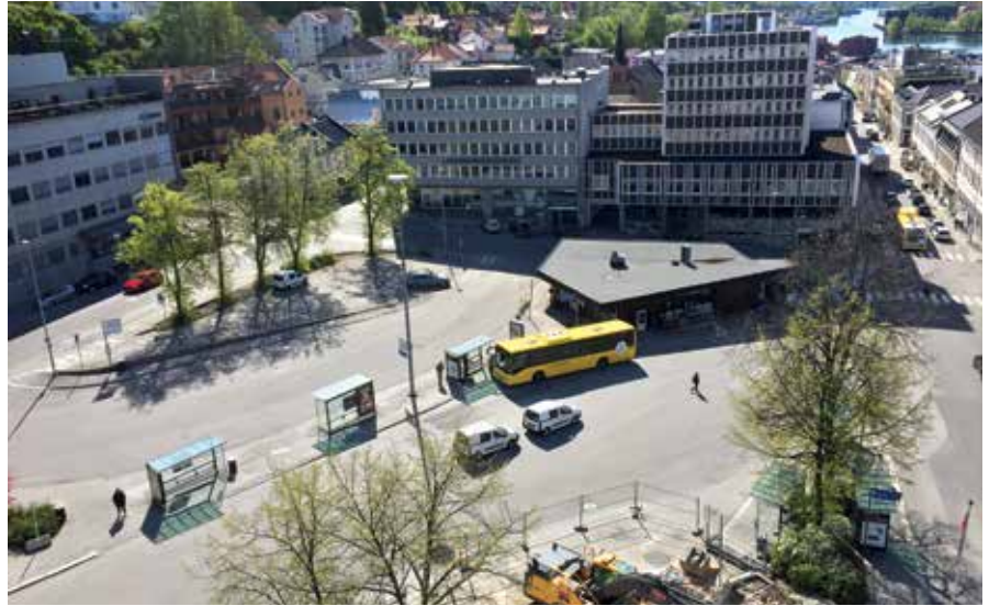
Landmannstorget før transformasjonen. Foto: Skien kommune
