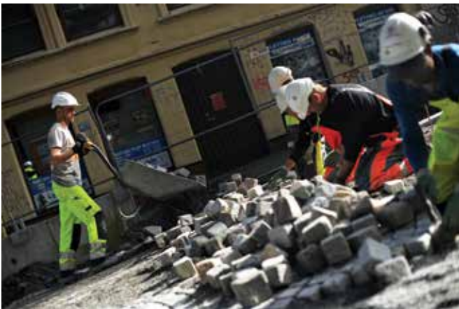
Figur 8. En håndlanger får fram og tilrettelegger steinen, slik at det blir god flyt i arbeidet. Foto: Svein Boasson AS
