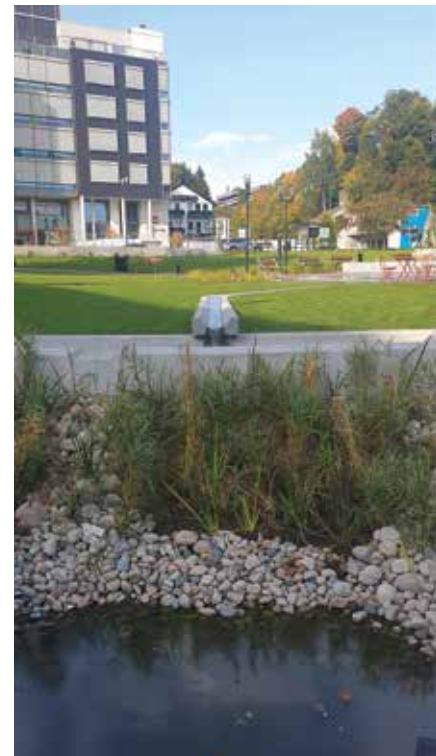
Vannet blir ledet i renne fra fonteneområdet og ender opp i et fordrøyningsbasseng i lavpunktet. Foto: Ragnhild Momrak
